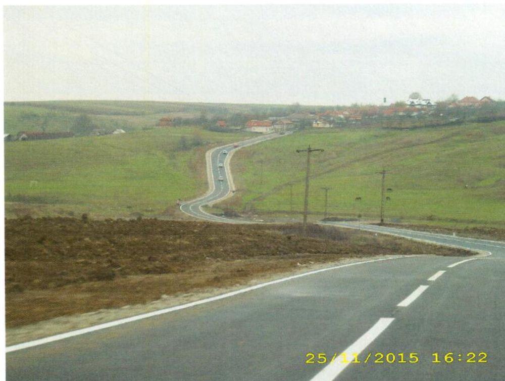
Modernizare DJ Lugoj-Hezeriș
